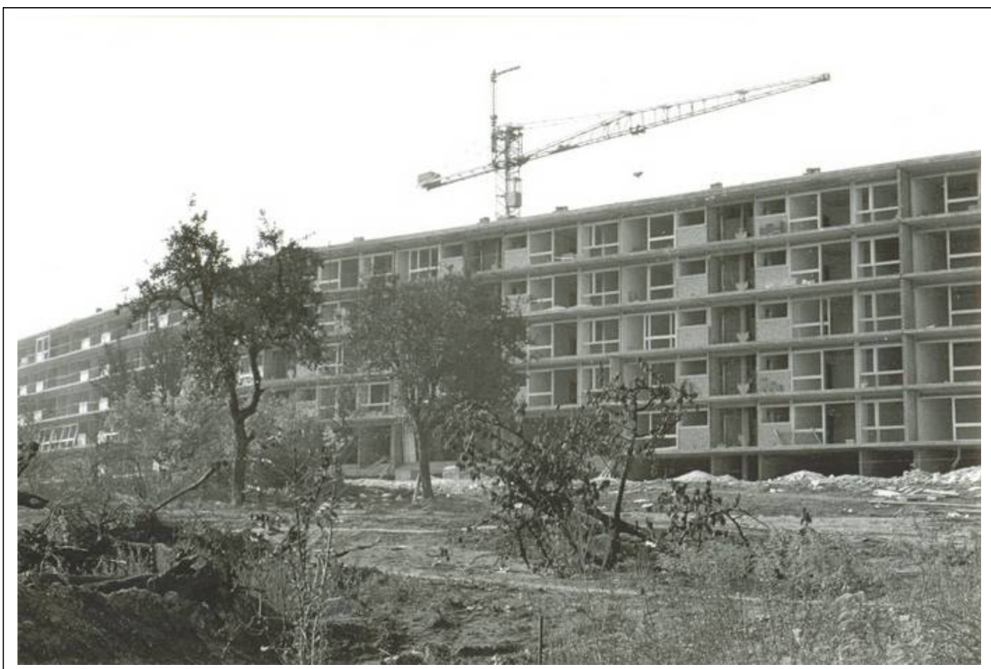
La construction de l'ensemble des Paradis (vers 1956 ?). AM FAR non coté
